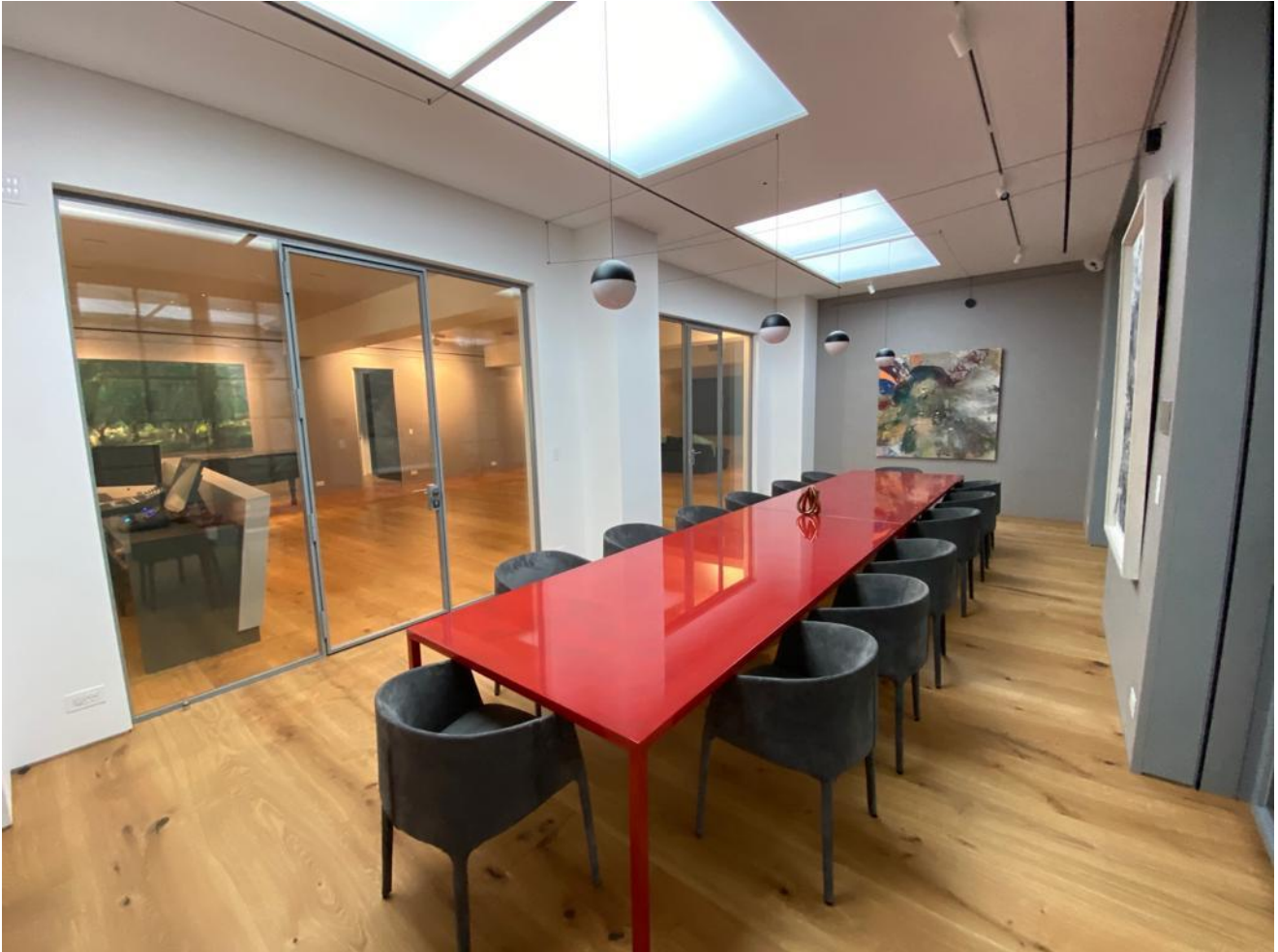
Diffusori ad alta induzione lineari a soffitto INDUL (riga nera sul soffitto a fianco al binario elettrificato)
