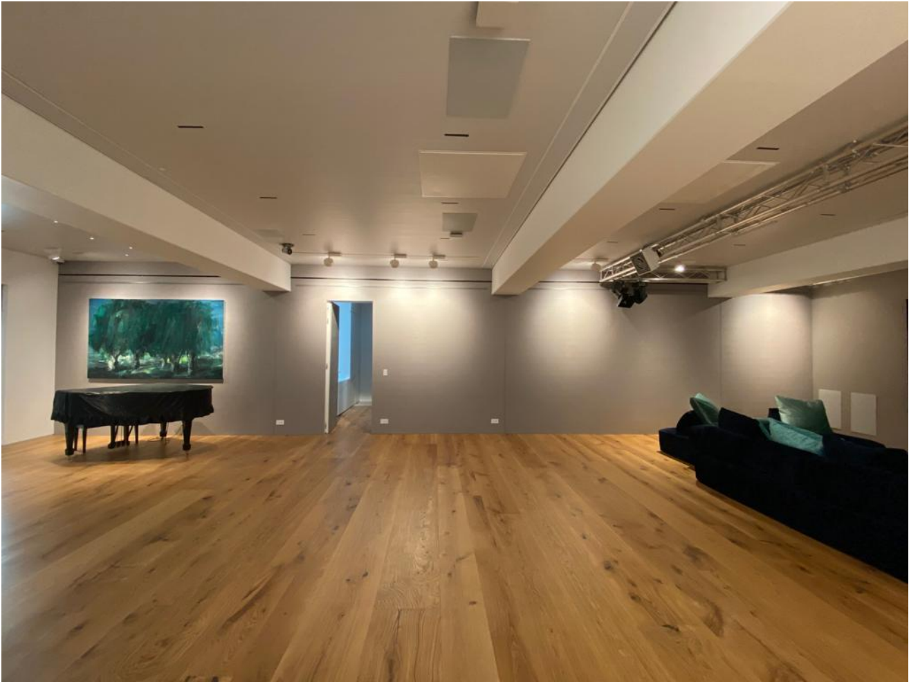
Diffusori ad alta induzione lineari a parete INDUL (riga nera sulla parete grigia in fondo)
