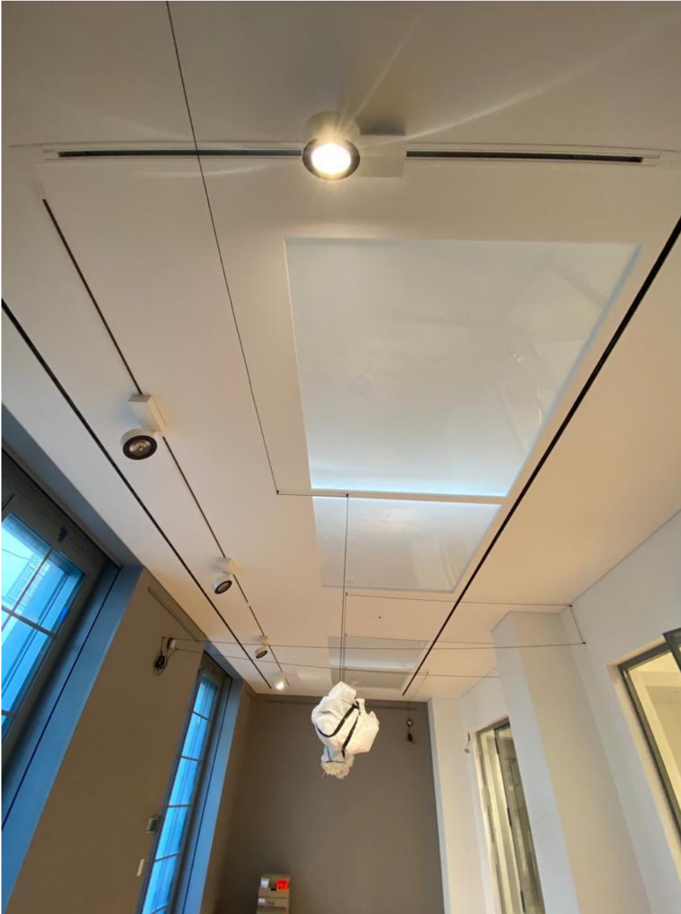
Diffusore lineare Indul a sinistra e a destra del binario elettrificato
