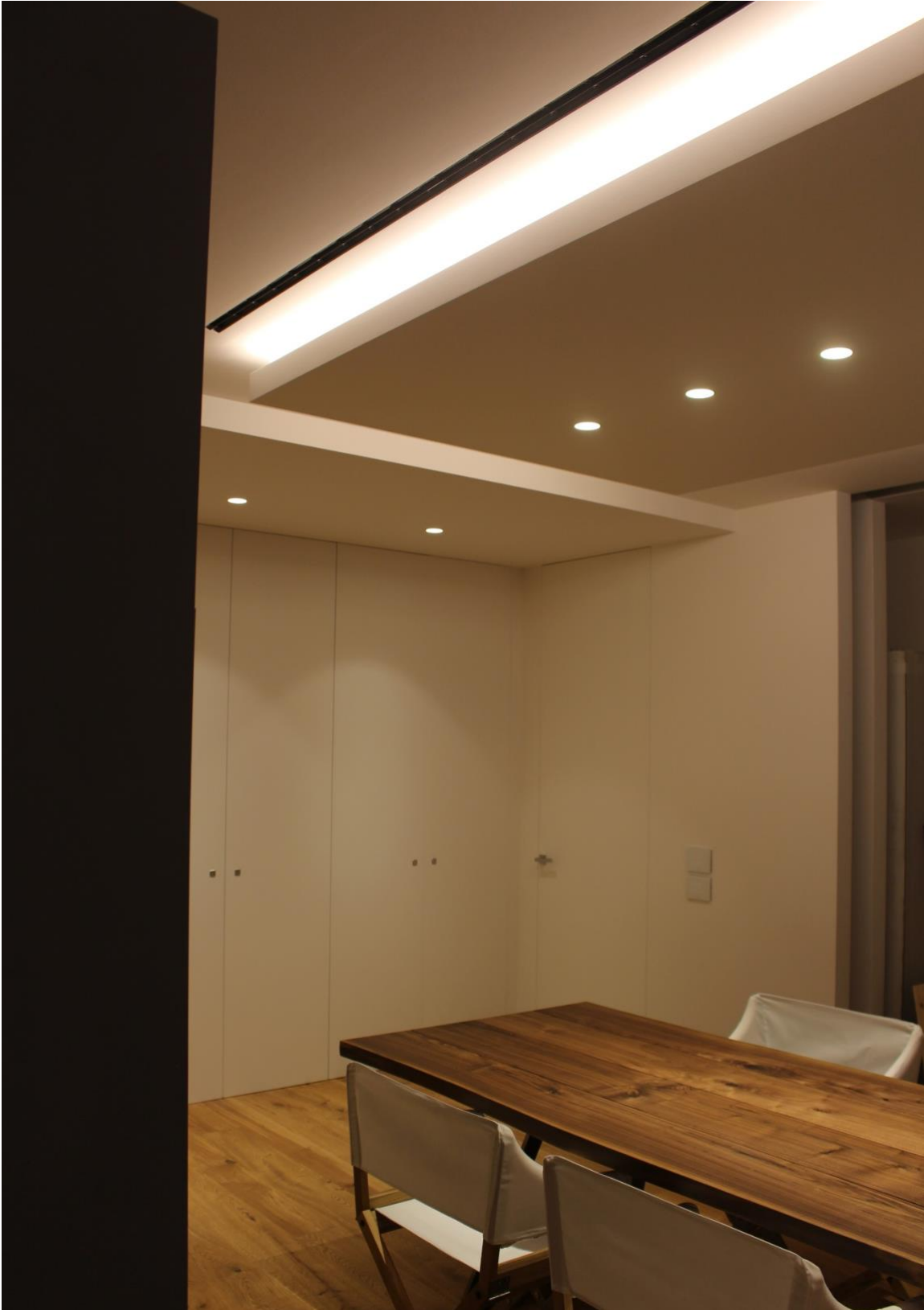
Diffusore lineare Indul V45 a soffitto – lancio a tutta altezza
